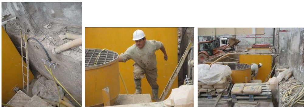
Acceso plataforma carga
