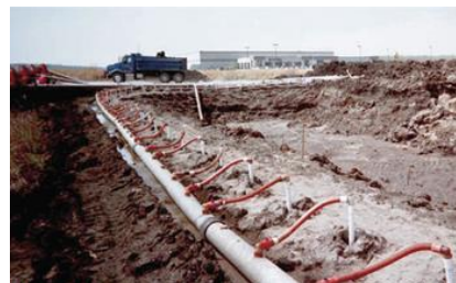
Aplicación en zanja
